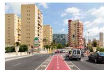
57. Puente Avda. Jaime I
