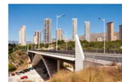
12. Puente de Xixo
